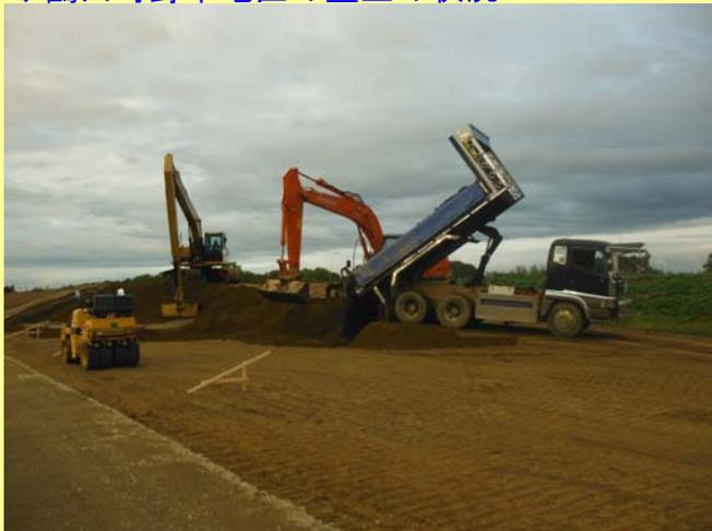
ダンプトラックで盛土箇所まで運搬し荷下ろしした後、規定の厚さで敷き均し転圧します。
