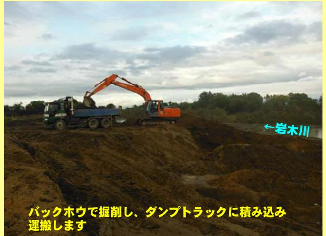
バックホウで掘削し、ダンプトラックに積み込み運搬します
